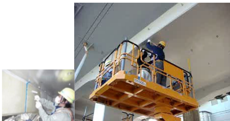
図-4 DLC 薄膜の貼付け施工
